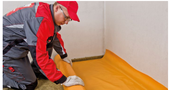
Рис. 8. Укладка гидроизоляции
