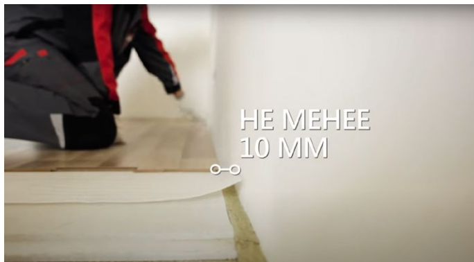
Рис. 15. Укладка ламината с зазором до стены 10 мм (в случае подрезки звукоизоляционных плит по периметру на уровне стяжки)
