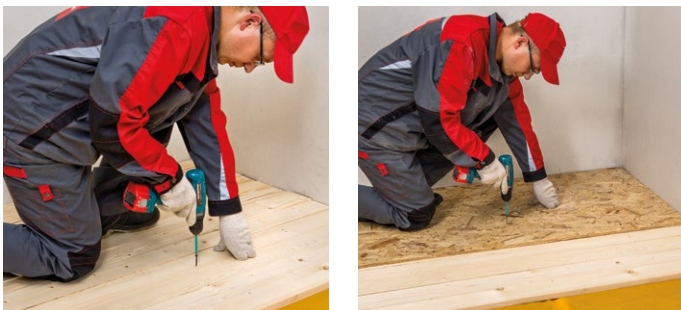
Рис. 4. Монтаж чернового пола
