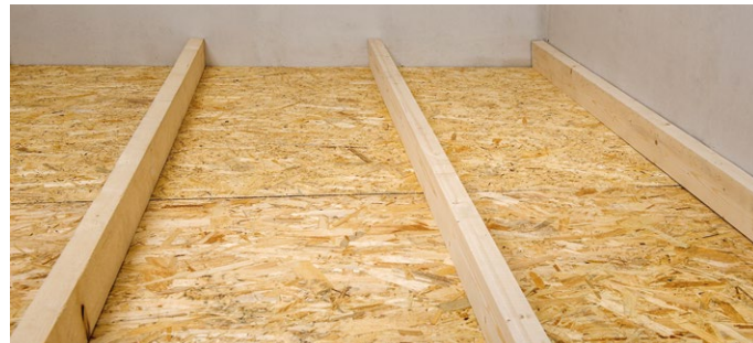
Рис. 1. Подшивка лаг снизу
