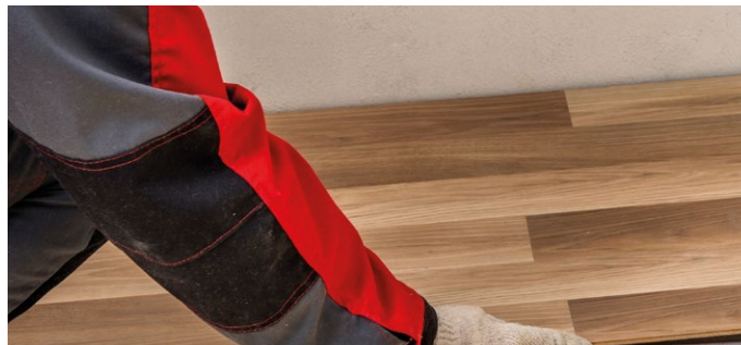
Рис. 13. Монтаж планок ламината
