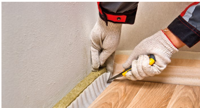
Рис. 14. Подрезка звукоизоляционных плит по периметру на уровне чистого пола
