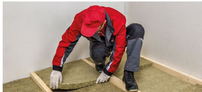
Рис. 2. Монтаж теплоизоляции враспор между лагами
