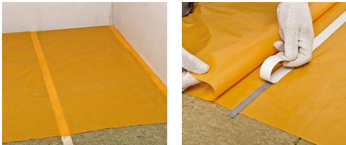
Рис. 3. Монтаж и проклейка нахлестов пароизоляционной пленки
