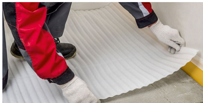
Рис. 12. Укладка подложки под финишное покрытие пола
