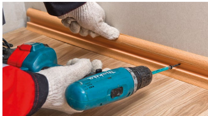
Рис. 16. Крепление плинтуса
