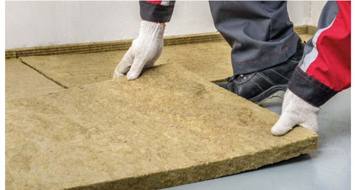
Рис. 7. Укладка плит ТЕХНОФЛОР СТАНДАРТ
