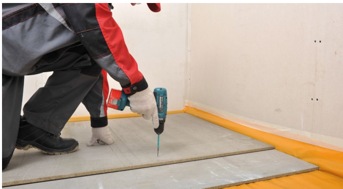
Рис. 9. Устройство сборной стяжки
